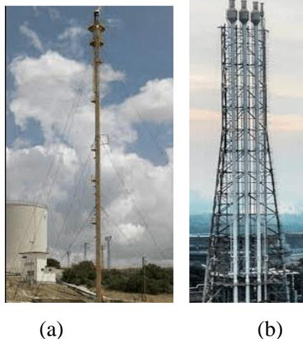
**Gambar 1.** Menara Obor dengan *Guy Wire* (a) dan *Derrick Structure* (b)
